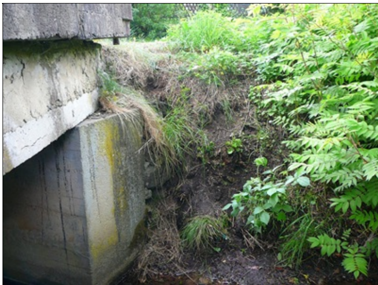
Chybějící křídla na pravé straně konstrukce
