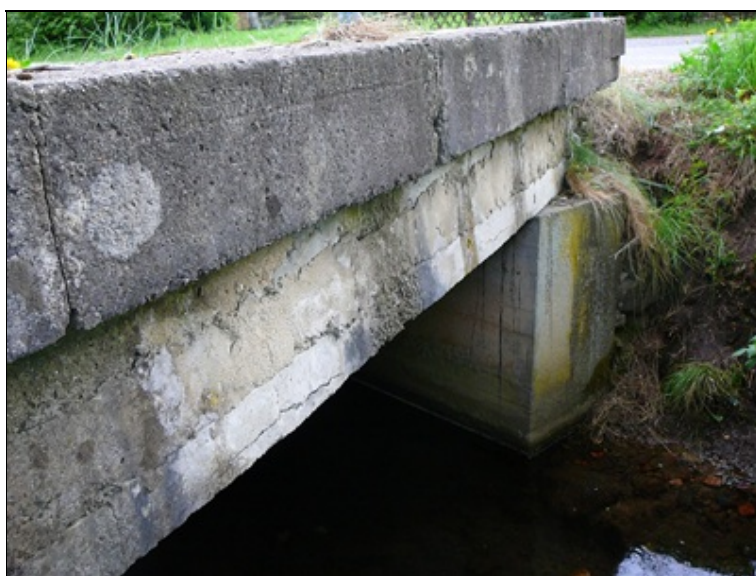
Pod římsami zatéká na boky konstrukce
