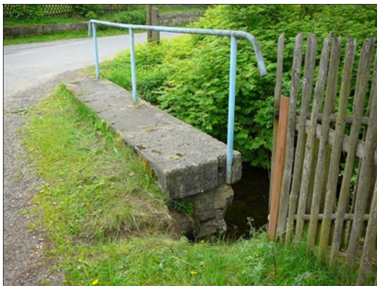
Chybějící křídlo u OP1 na pravé straně, skluzem teče přímo na opěru
