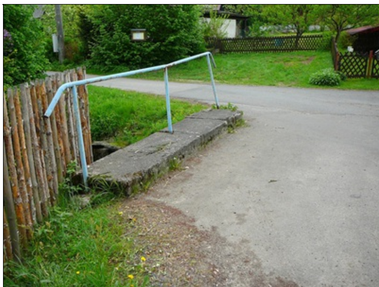
Zábradlí nevyhovuje ČSN je v havarijním stavu
