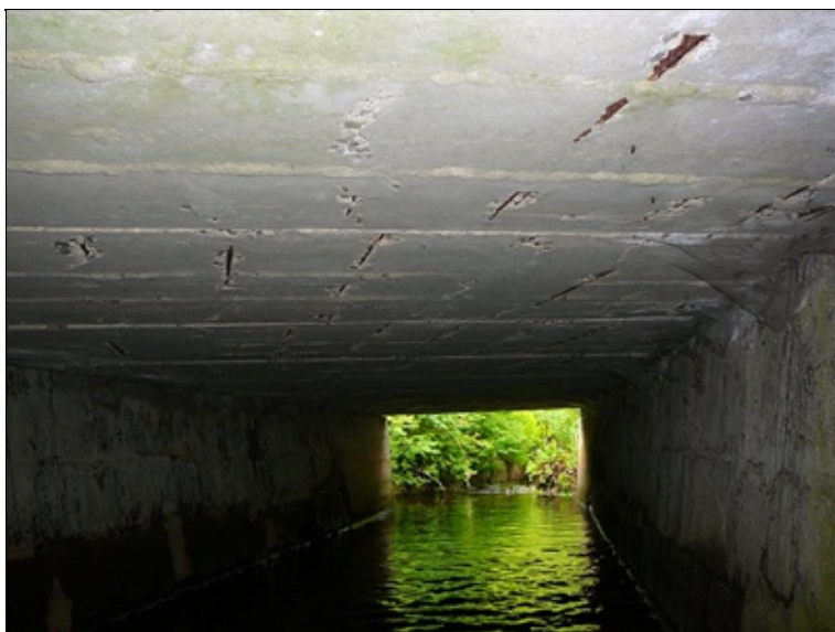
Podhled NK, obnažená korodující výztuž
