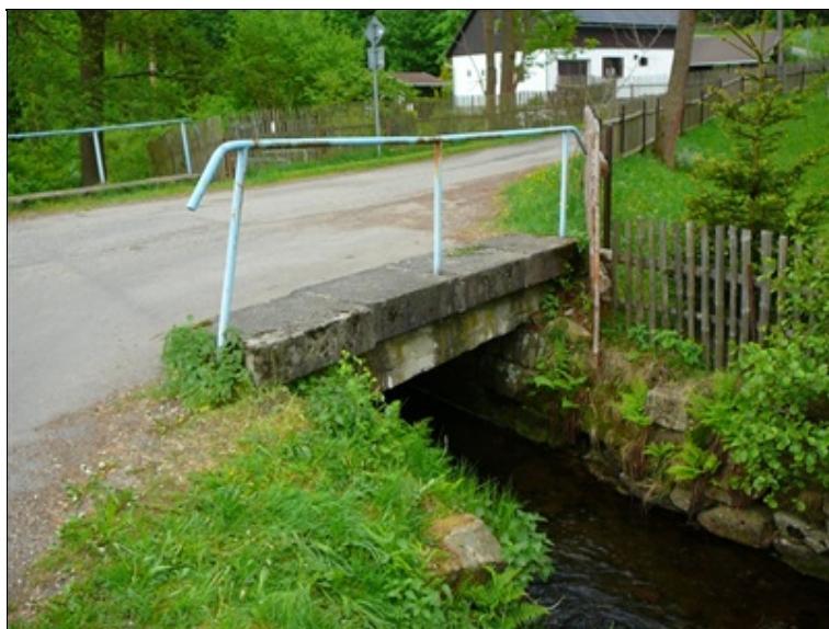
Pohled na levou stranu konstrukce, rozvolnění křídel na vtokové straně
