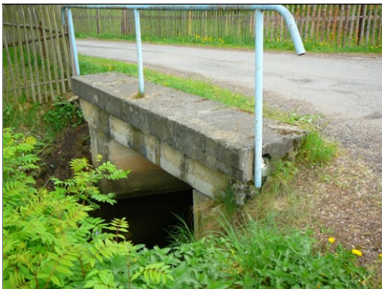
Pohled na pravou stranu konstrukce, křídla zcela chybí
