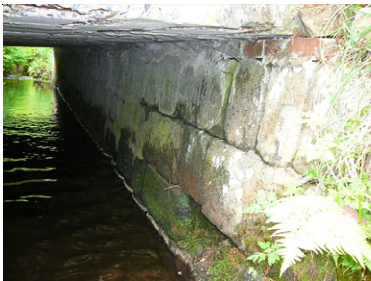
Pohled na OP1, uchycená vegetace, vypadlé spárování, lokální kaverny
